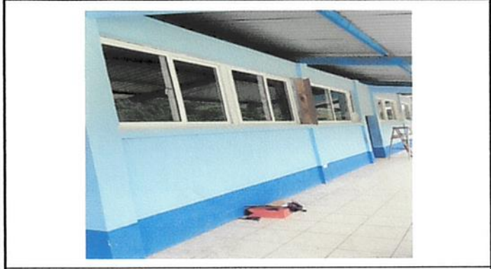
Foto1: Instalación de ventanas de PVC.
