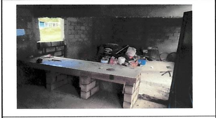
Foto 2: Mejoramiento de instalación de cocina y bodega.
